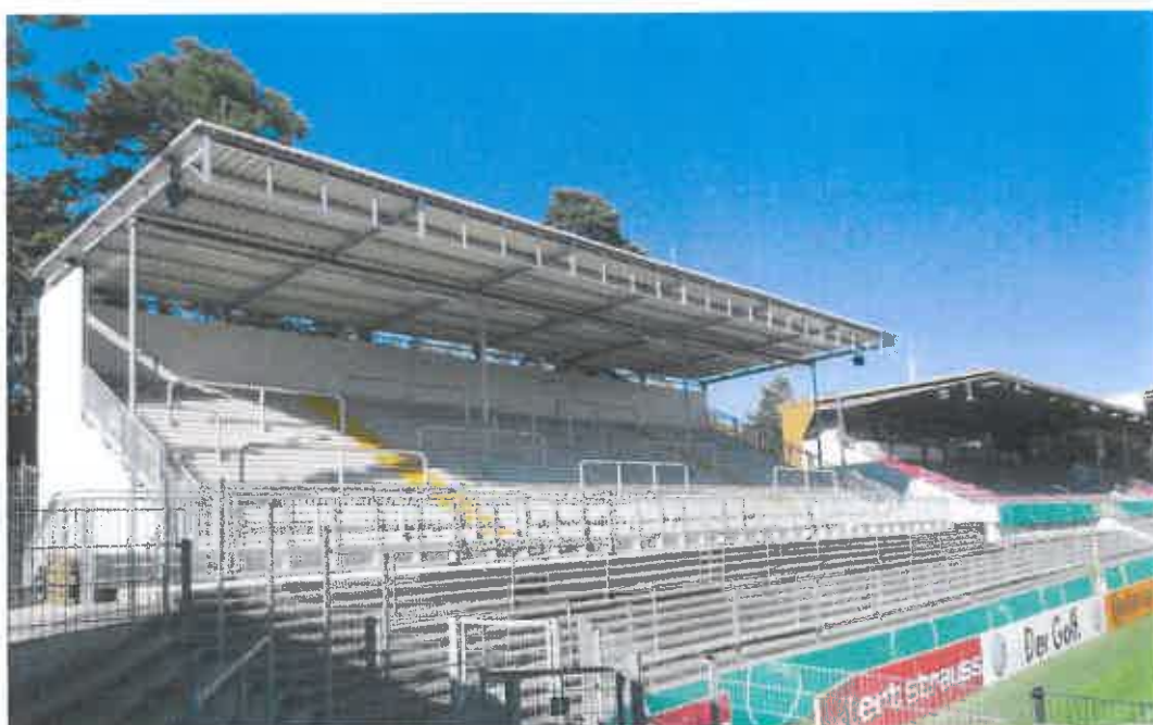
Überdachte Stehplatztribüne, SV Sandhausen
